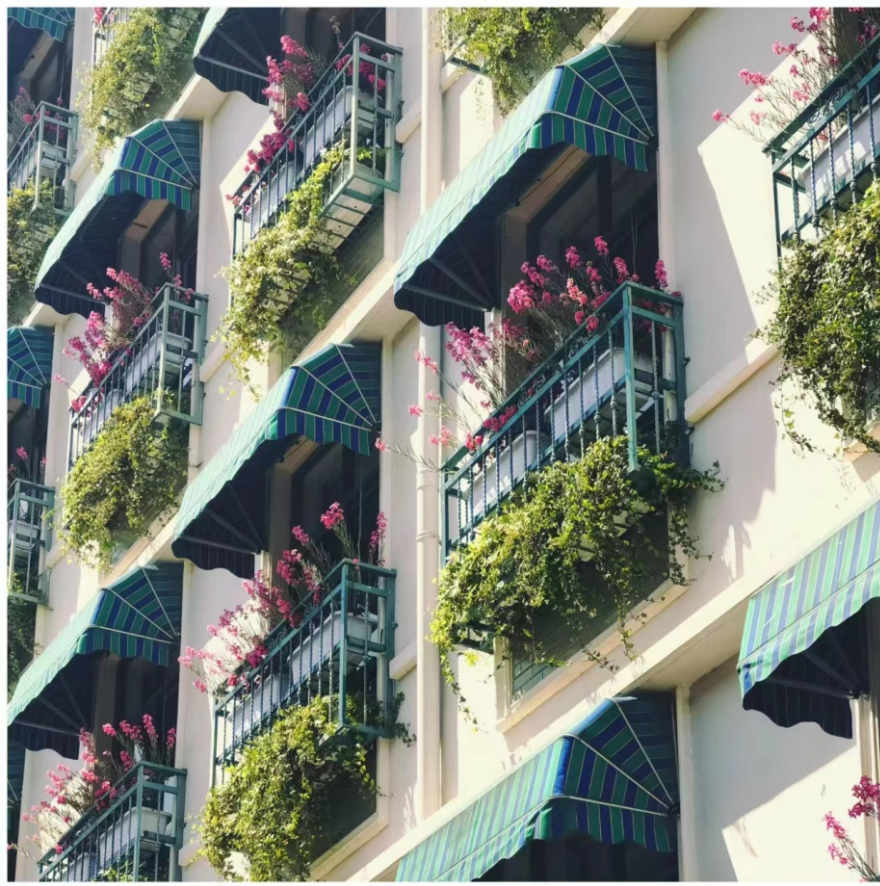
下乡路上发现美丽乡村建设的成果： 老旧房屋修缮后焕然一新的面貌
